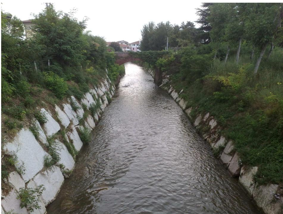
**Foto n.2: - Difese di sponda lungo il corso del T. Muson a sud di via Circovallazione ovest**
