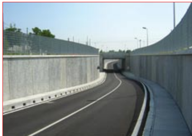
Sottopasso di Via Favaretti, lungo la linea ferroviaria per Padova.
