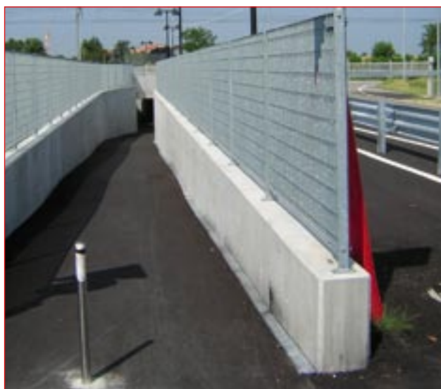
Sottopasso ciclopedonale di Via Fornace a Treville.
